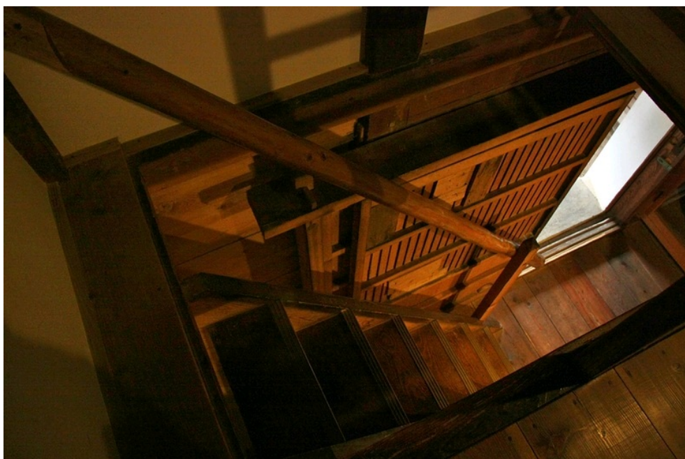
Кошмарно крутая лестница на второй этаж склада.
