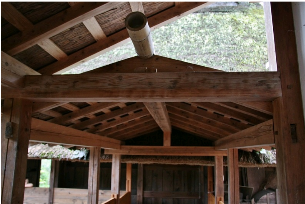
Крыша коридора-перехода от склада к дому. Стена дома и кусок крыши видны на заднем плане.
