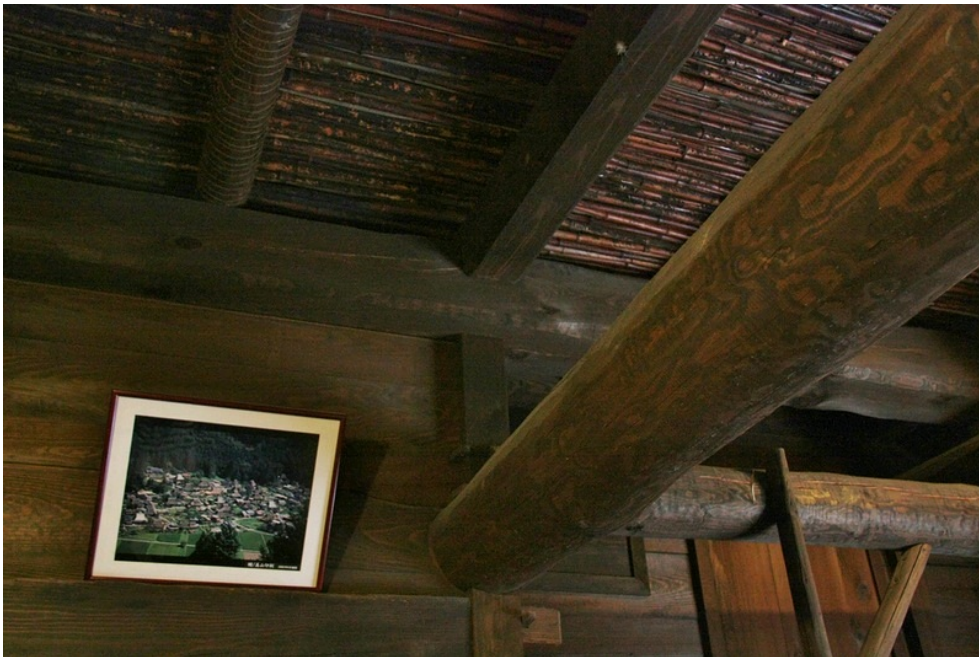
Потолок гостиной-спальни. И центральная балка дома, станова жила.
