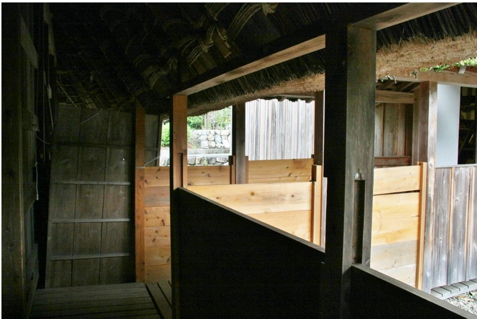
И идем вдоль открытой галереи гостиной-столовой в узкий коридор, соединяющий основное здание (стена слева этому основному зданию и принадлежит) со складом.
